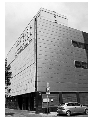
Edificio de la mutua de seguros.
